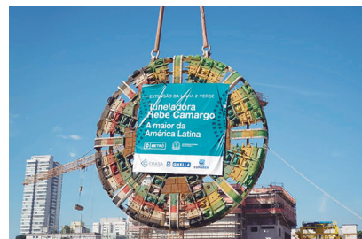
Roda de corte da tuneladora Hebe Camargo desceu para a vala de montagem na futura Estação Penha em julho.
