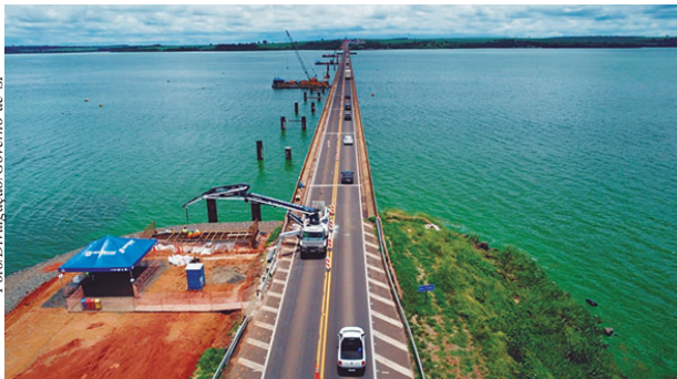
A duplicação da maior ponte de São Paulo também exige operação sobre o Rio Tietê, com balsas, embarcações de apoio e fundações dentro do rio
