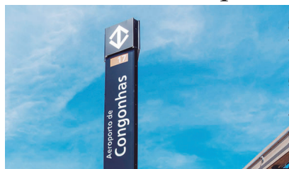
Estação possui plataforma central de 60 metros, preparada para atender mais de 13 mil passageiros por dia, com potencial de crescimento ao longo dos anos
