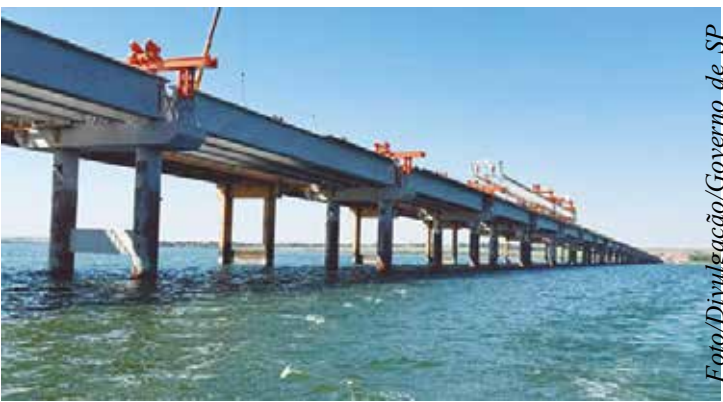
Governo de SP acompanha visita técnica às obras da maior ponte do Estado
