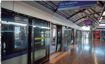
acesso, mezanino e plataforma, que é coberta com estrutura metálica em forma de arco. O revestimento dos pisos é de granito e as paredes internas têm pastilhas cerâmicas e fechamento em vidro.
