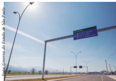
Etapa final do conjunto de obras do Corredor Leste-Oeste
