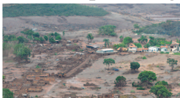
Rompimento da barragem em Mariana MG
