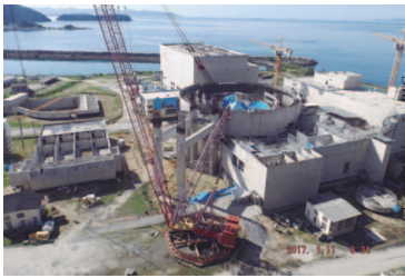
Obras da Usina Nuclear de Angra 3
