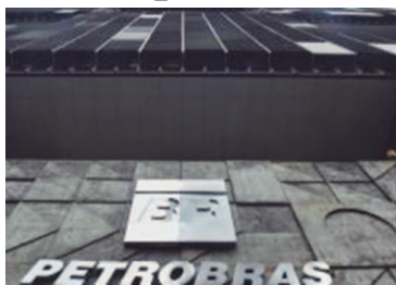
Edifício-sede da Petrobras, no centro do Rio
