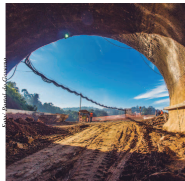
O túnel 301 é o mais extenso dos 7 túneis do Rodoanel Norte
